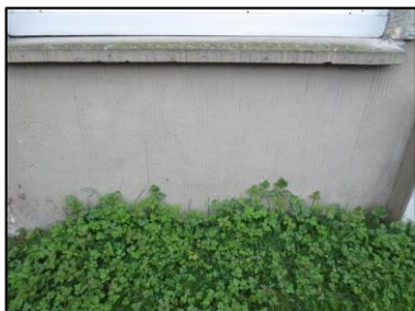
Photo N° 2896 ECH-N°36 -- Batiment 28-36 republique façade parking Murs soubassement béton+peinture
