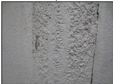
Photo N° 2893 ECH-N°33 -- Batiment 28-36 republique façade parking Poteaux béton+peinture
