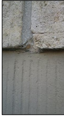
Photo N° 330 ECH-N°41 -- Batiment 24-26 republique pignon Murs Joint entre pierres
