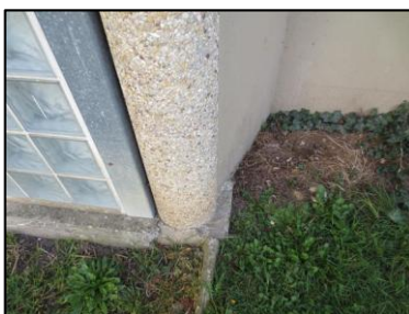
Photo N° 2866 ECH-N°20 -- Batiment Laennec façade jardin Poteaux béton+pierres
