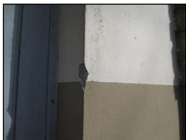
Photo N° 2856 ECH-N°13 -- Batiment 23-31 republique façade jardin Murs béton+peinture beige
