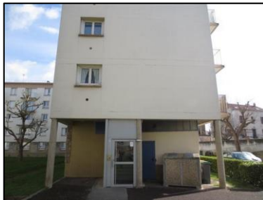
Photo N° 2888 ECH-N°39 -- Batiment 28-36 republique façade parking Murs béton+peinture beige
