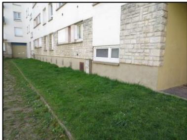
Photo N° 2887 ECH-N°31 -- Batiment Ambroise façade jardin Murs soubassement béton+peinture
