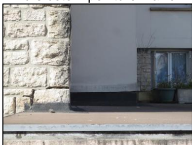
Photo N° 2872 ECH-N°22 -- Batiment Laennec Toiture chaufferie Shingle
