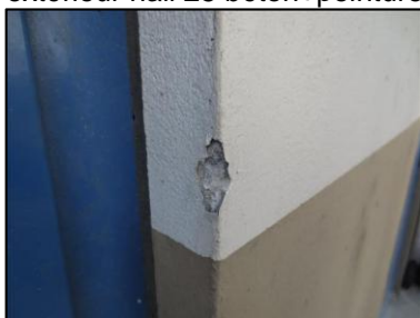
Photo N° 2844 ECH-N°7 -- Batiment 23-31 republique Murs béton+peinture beige
