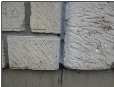
Photo N° 2894 ECH-N°34 -- Batiment 28-36 republique façade parking Murs Joint de dilatation+mousse
