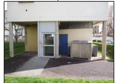
Photo N° 2889 ECH-N°32 -- Batiment Ambroise façade jardin Murs béton+peinture beige
